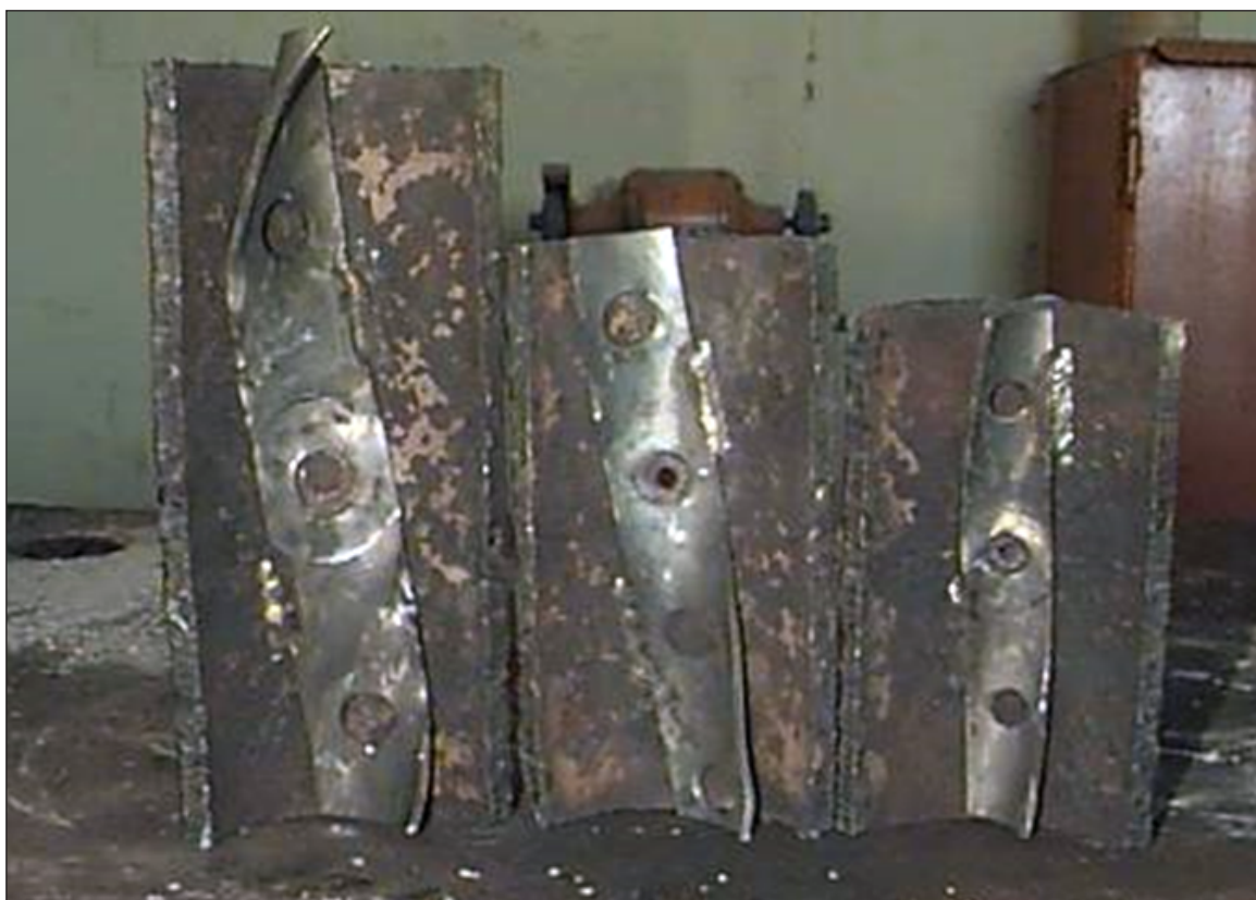
Figura 14. Detalle de los impactos sobre las placas de tubería de revestimiento.
