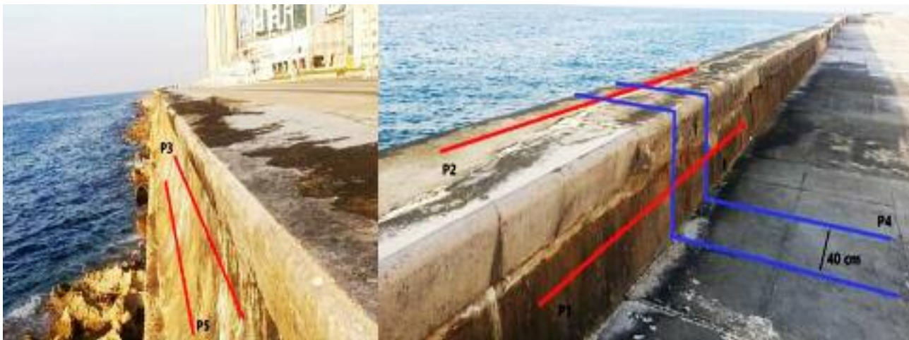
Figura 9. Variante de adquisición. Cuatro perfiles longitudinales (color rojo) y una serie de perfiles transversales (color azul). Tomada por el autor.
