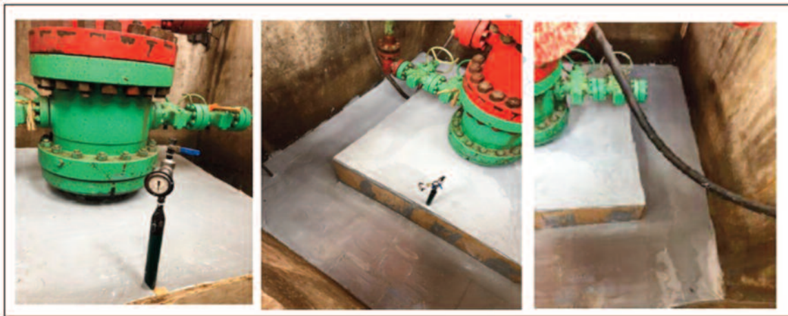
Figura 5. Encapsulado de contrapozo
