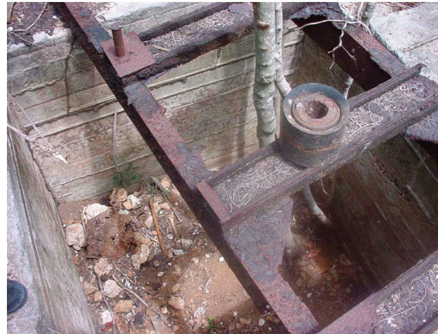
Figura 4. Foto actual de la boca del pozo Nipe No. 2 en el poblado El Ramón de Antillas, provincia de Holguín.
